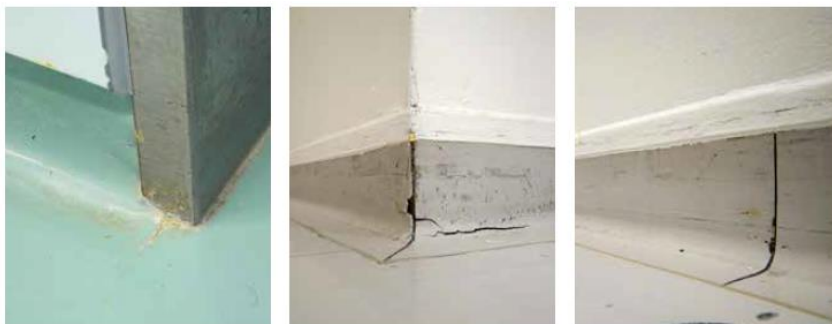
شکل ۱- دوام نامناسب کفپوش های وینیل از محل درزهای جوش با گذشت زمان
