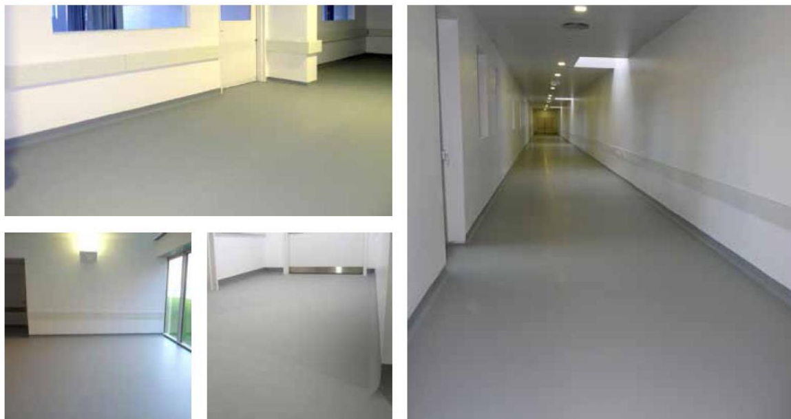
شکل ۵- اجرای کفپوش اپوکسی در بیمارستان سوسا مارتیز شهر گواردا در پرتغال [۱۵]
