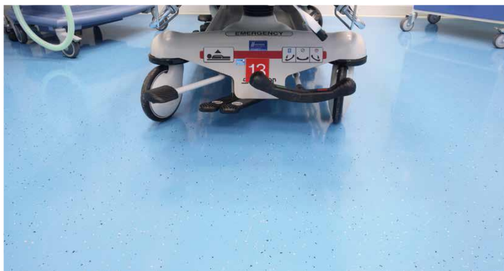
شکل ۲- اجرای پیوسته کفپوش های اپوکسی درجا و بدون درز در طیف های رنگی متفاوت
