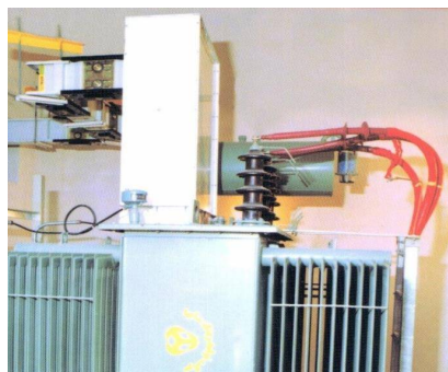
کاربرد در پستهای برق-اتصال ترانس
